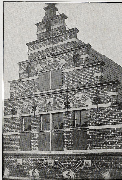
Gevel Menstraat No. 9.
