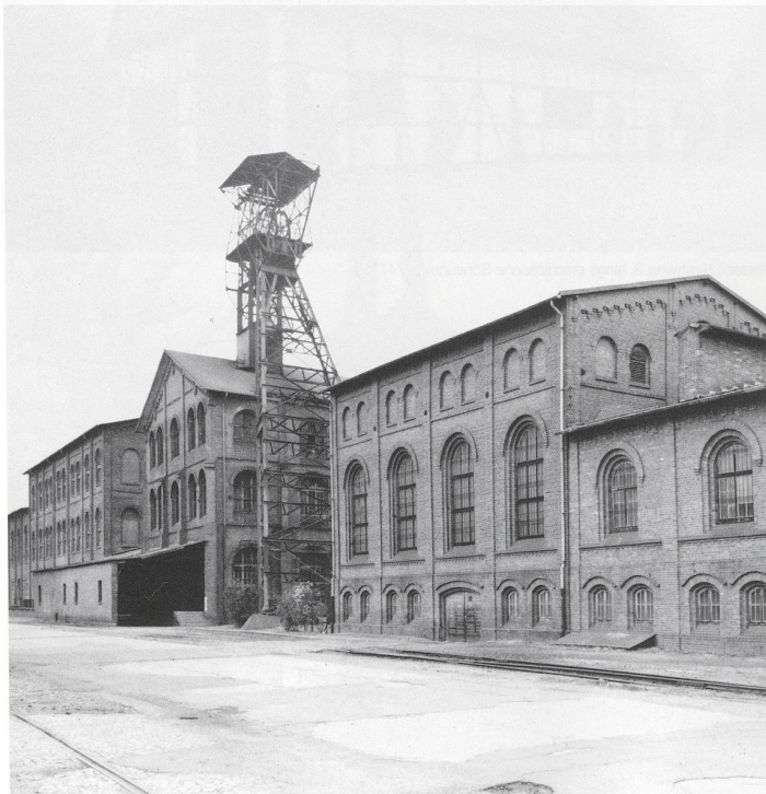
Wehmingen, ehem. Kalibergwerk Hohenfels, Betriebsgebäude, Zustand 1981 (Bildarchiv des Nieders. Landesamtes für Denkmalpflege)
