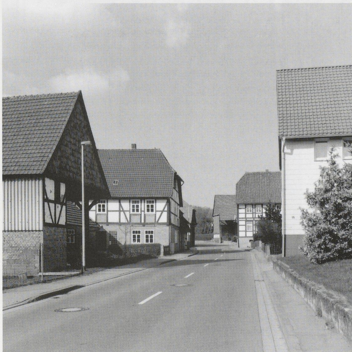
Wachenhausen, giebelständige Wohn- und Wohnwirtschaftsgebäude an der Ortschaftsstraße
