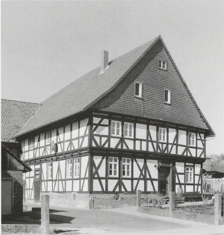
Wachenhausen, Hauptstraße 30, Wohnhaus der Hofanlage, dat. „1722“
