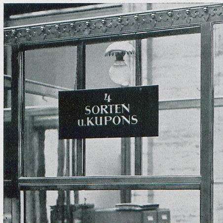
SCHRIFTSCHILD AN EINEM BANKSCHALTER Grund: schwarzes Glas, Schrift: goldnes Überfangglas Entwurf: Hertha Jeß, Berlin
