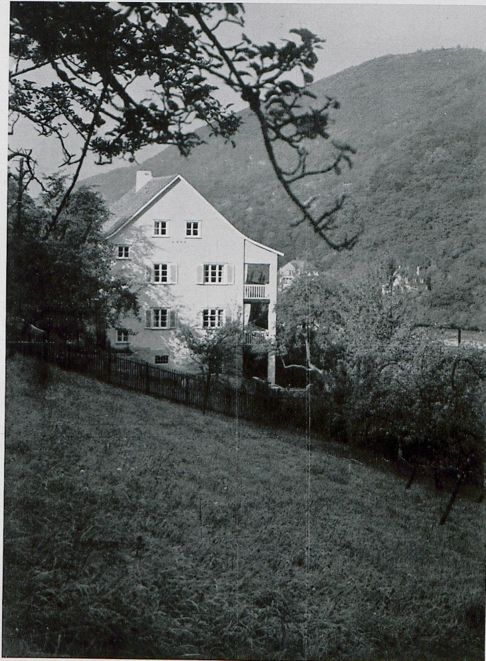
Das Haus steht in der Nähe von Heidelberg auf einem Wiesenhang inmitten großer Obstbäume. Putz weißlich-gelb. Fenster weiß, Umrahmung und Läden graugelb. Sockel gelblicher Sandstein. Es enthält in den beiden Geschossen zwei selbständige Wohnungen für zwei verwandte Familien.
