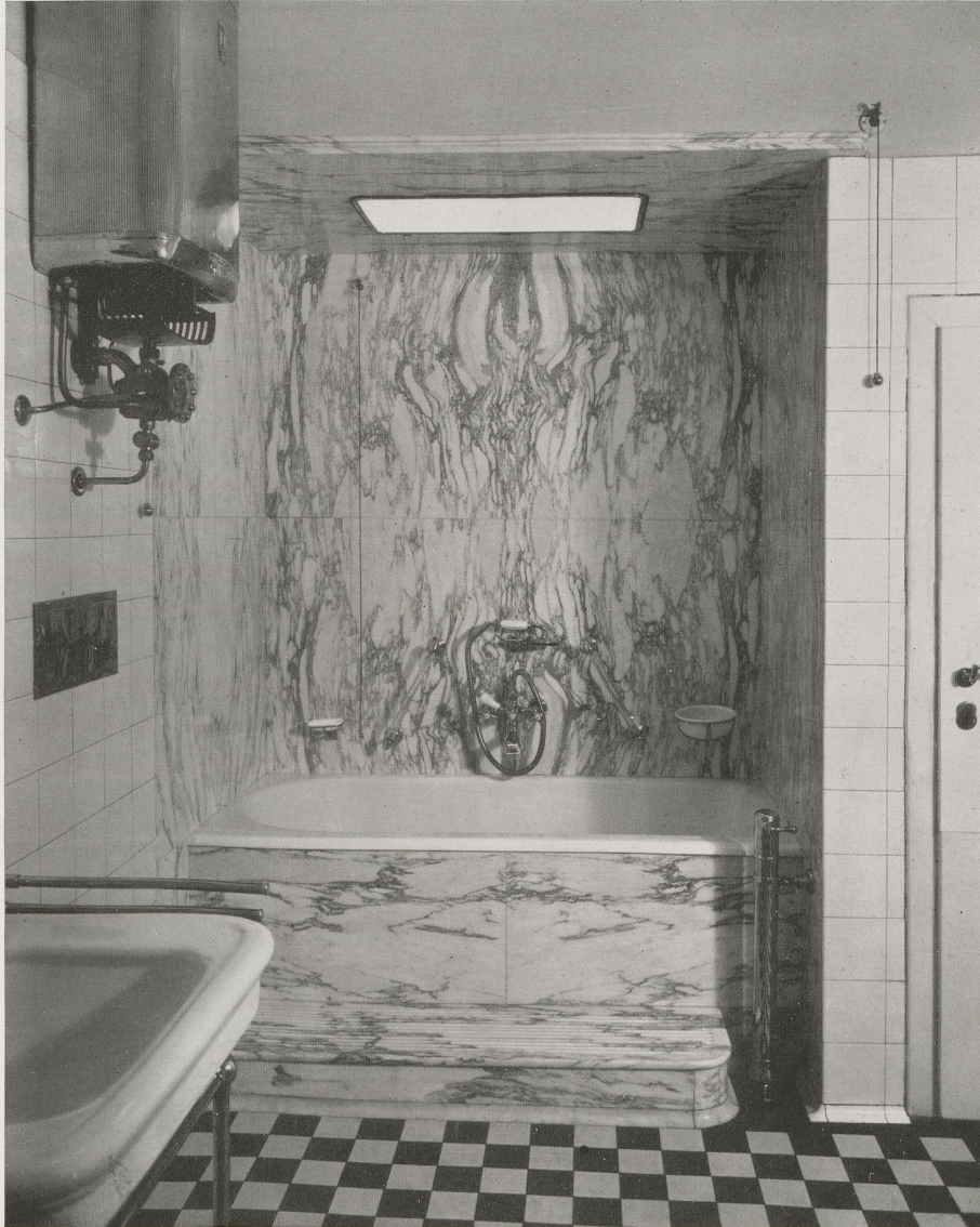
ARCHITEKT FRITZ GROSS – WIEN. »BADEZIMMER«. WOHNUNG Dr. B. – WIEN EINGEBaute WANNE IN PIASTRAZZIA-MARMOR. WEISSE FLIESEN-VERKLEIDUNG
