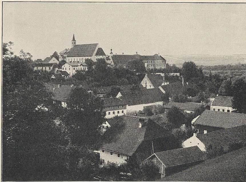
Fig. 64. Niederviehbach. Ansicht des Klosters von Südosten.
