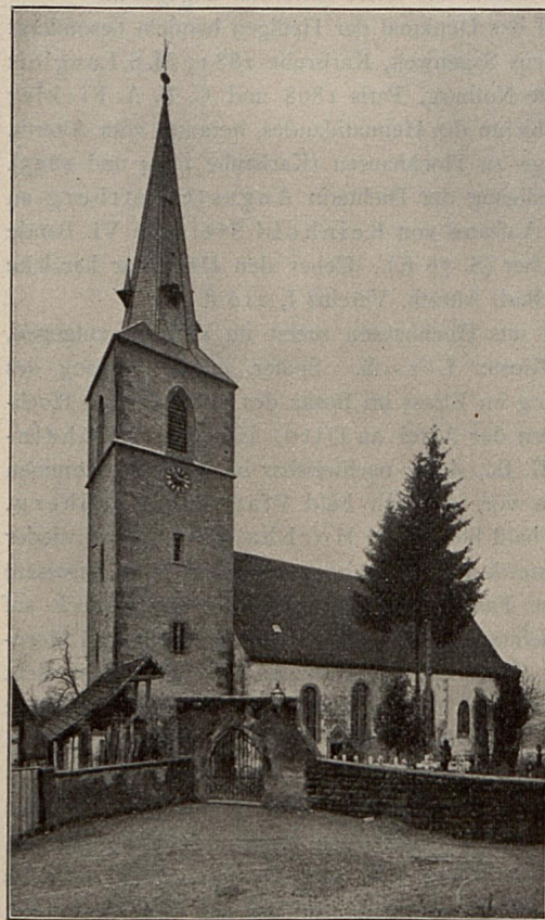
Fig. 20. Kirche zu Hochhausen.
