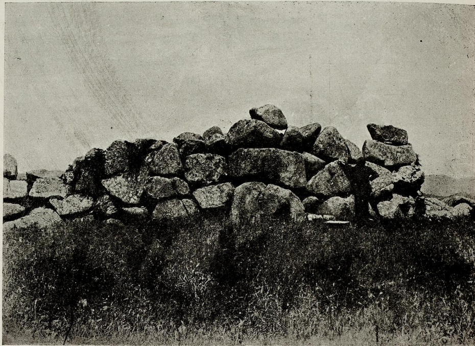
FIG. 35. — Particolare della fronte verso monte del recinto Corona e' Crobu , presso Nureci.
