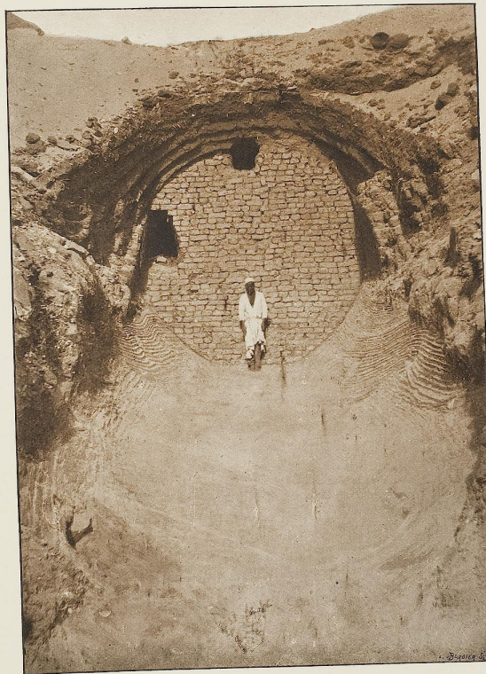
Fouilles au sud-ouest. La grande voûte. — 5 Mai.
