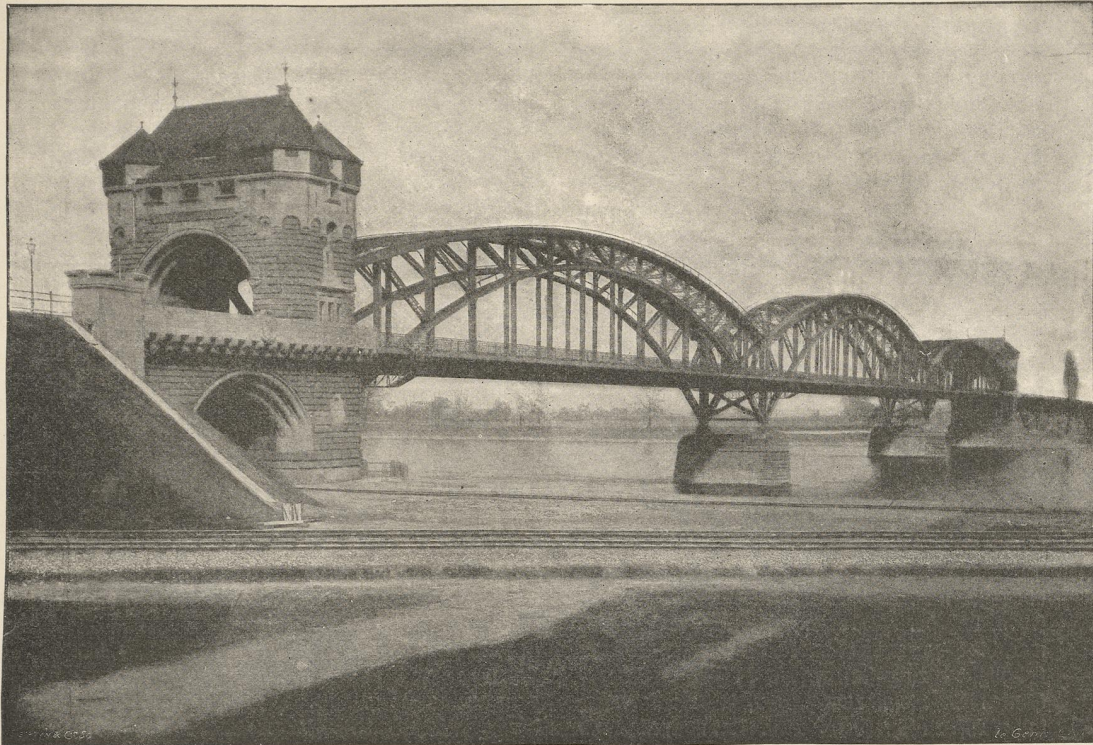
Abb. 1. Eisenbahnbrücke über den Rhein bei Worms.
