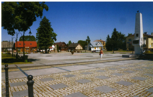
21. Rynek, stan po rewaloryzacji. Fot. Z. Cybulko, 2015. Market square, state after revalorisation. Photo: Z. Cybulko, 2015.
