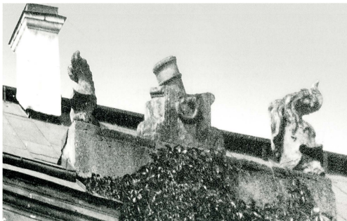
1. Fragment zdjęcia z roku 1920, przedstawiający kompozycję rzeźbiarską na elewacji budynku Arsenalu przy pałacu Branickich w Białymstoku. Autor nieznany Fragment of an archival photograph from the 1920s with a sculpted composition of the elevation of the Arsenal next to the Branicki Palace in Białystok. Author unknown.
