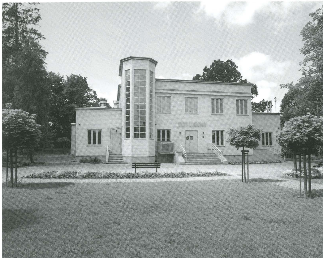
2. Supraśl, Dom Ludowy. Widok od ul. Piłsudskiego (wsch.), stan po remoncie.
