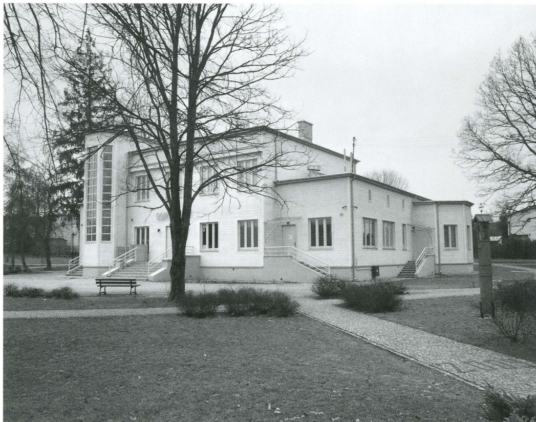
5. Supraśl, Dom Ludowy. Elewacja frontowa (wsch.) i boczna (pn.), stan po remoncie.
