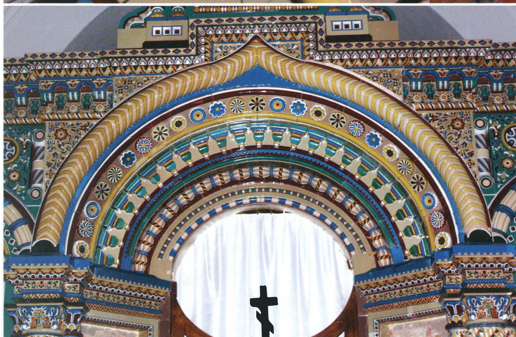
46. Montaż dekoru na rekonstruowanym łuku archiwolt. Assembly of a panel on a reconstructed archivolt arch.
