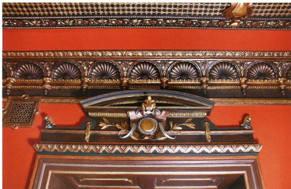
32. Kancelaria. Supraporta z fragmentem wystroju sztukatorskiego sufitu po konserwacji. Fot. K. Michałowski. Chancery. Supraporte with a fragment of the ceiling stucco outfitting after conservation. Photo: K. Michałowski.
