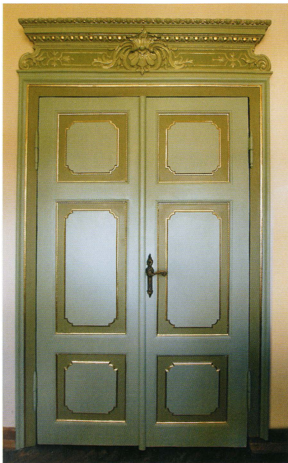
18. Stolarka drzwiowa „łącznika” wraz z supraportą po konserwacji. Fot. K. Michałowski.
