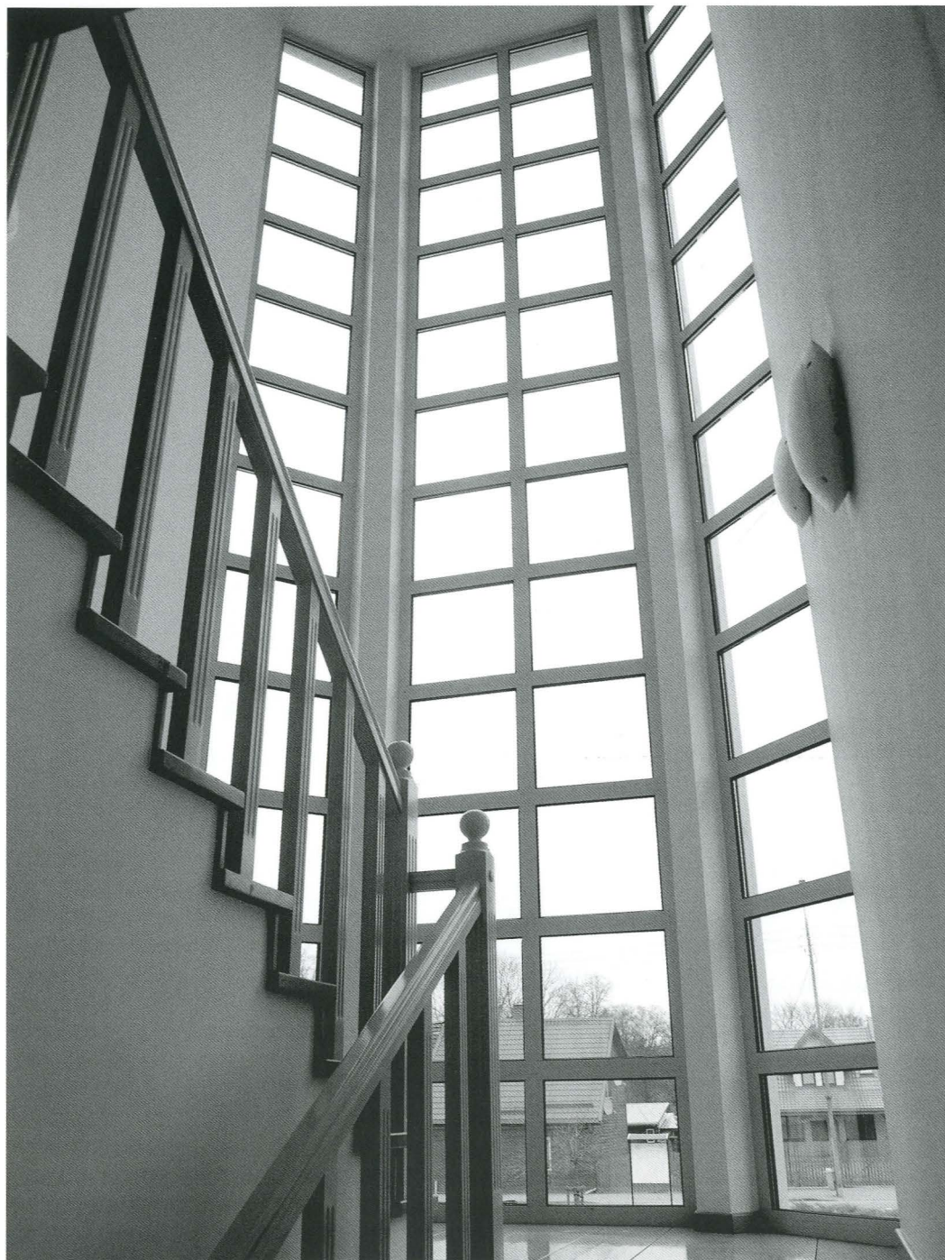
1. Supraśl, Dom Ludowy. Wnętrze – frontowa klatka schodowa, stan po remoncie. Fot. Aneta Kułak, luty 2016. Supraśl, Folk House. Interior – front staircase, state after renovation. Photo: Aneta Kułak, February 2016.
