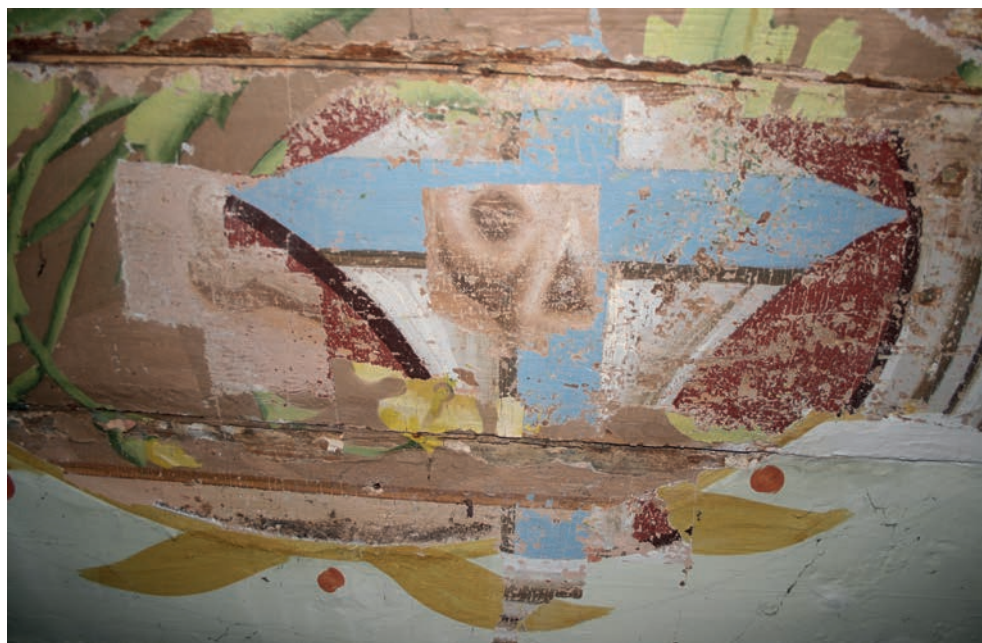
5. Turośl. Kościół pw. św. Jana Chrzciciela. Prace konserwatorskie przy polichromii stropu, centralnie widoczna najstarsza polichromia z lat siedemdziesiątych XIX w., 2016. Fot. M. Andron Turośl. Church of St. John the Baptist. Conservation of ceiling polychrome, in the centre: the oldest polychrome from the 1870s, 2016. Photo: M. Andron
