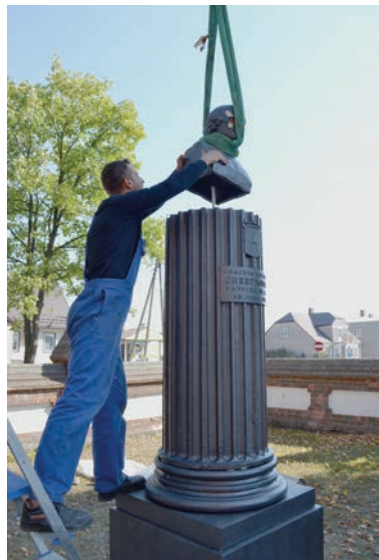
12. Pomnik Joachima Litawora Chreptowicza w Sztablinie, detal. Etapowe oczyszczanie i zabezpieczanie powierzchni rzeźby. Fot. K. Tałuż, 2018 The monument of Joachim Litawor Chreptowicz in Sztablinie, detail. Staged cleaning and protection of the sculpture's surface. Photo by K. Tałuż, 2018
