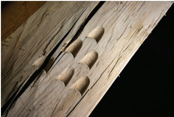
9. Ciesielskie oznaczenie montażowe na elemencie ramy stolcowej więźby kościoła w Niedźwiadnej. Fot. M. Warchoł Carpenter's mark on the element of the joiner's frame of the truss in Niedźwiadna. Photo by M. Warchoł
