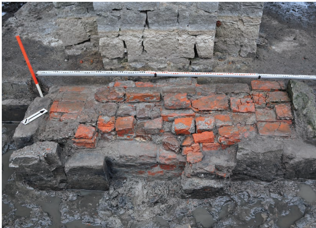
16. Białystok, stan. 1 - Ogród Branickich. Most na kanale. Relikty drugiego filara historycznego mostu zabezpieczone płytami betonowymi podczas budowy nowego mostu. Fot. M. Kozieł Białystok, site 1 - The Branicki Garden. The canal bridge. Relics of the historic bridge's second pillar, secured with concrete slabs during the construction of the new bridge. Photo by M. Kozieł
