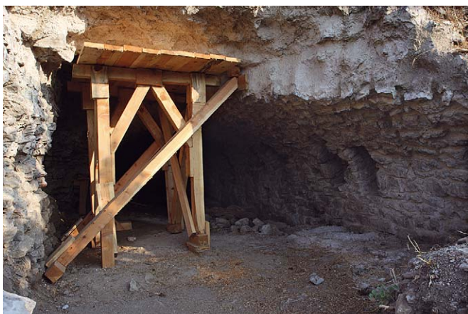
3-4 Kammer 1: provisorische Sicherung (Juni 2011)
