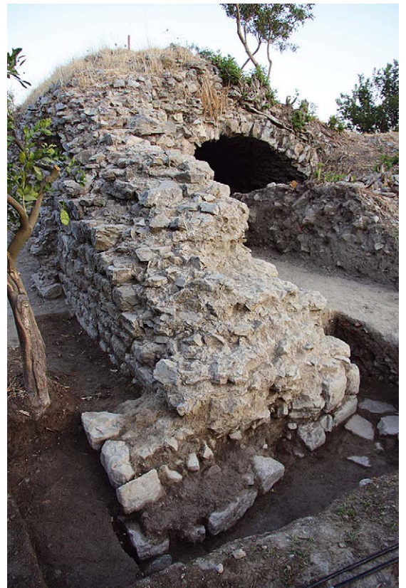
3 Südostecke: Gewölbe von Kammer 1 vor partiellem Einsturz im Januar 2010
