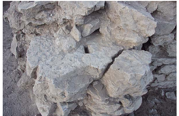
3 Nordfassade: Kämpferblock zwischen K7 und K8
