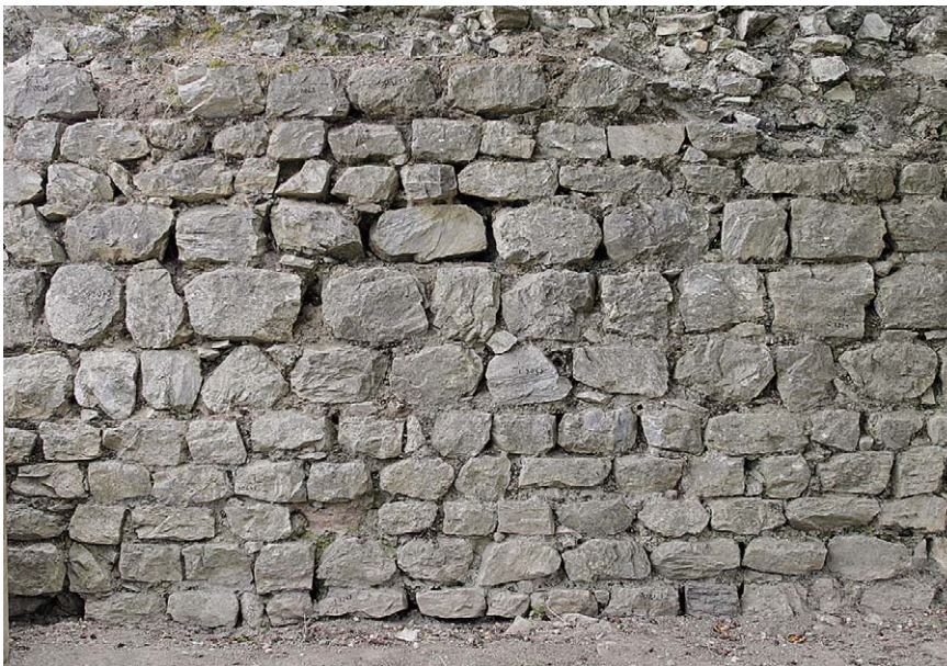
2 Westfassade: opus vittatum -Schale
