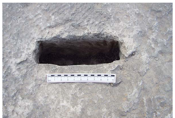
5 Nordfassade, Bogenblock: Zugang Kammer 9, Wolfsloch, Detail
