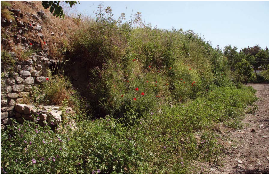
1 Westfassade vor der Freilegung (Mai 2010)
