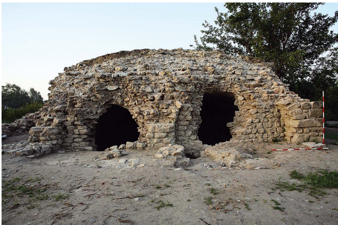
2 Nordfassade vor der Sicherung (2009)
