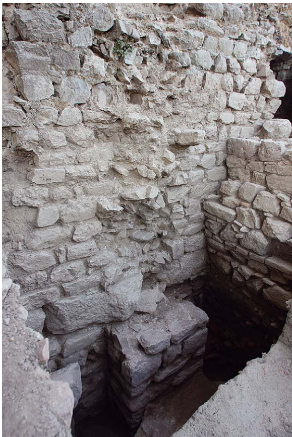
2 Westfassade, Sondage 1/2009: Pilaster in situ , darüber Ausriss Spuren
