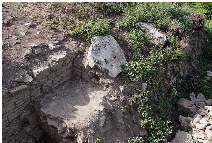
1 Kalksteinblock A 11 des umlaufenden Gurtgesimses: Fundlage
