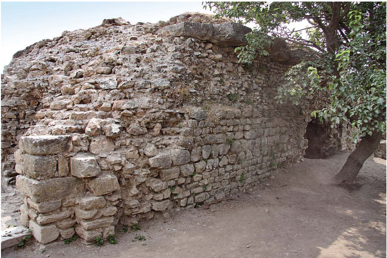
1 Nordwestecke mit Gurtgesims aus Kalksteinblöcken in situ
