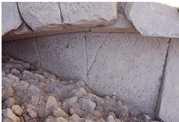
5 Ima Cavea: Marmordeckplatten in situ
