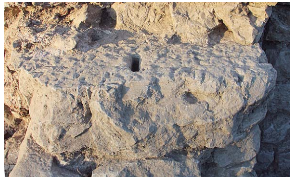
2 Nordfassade: Kämpferblock zwischen K6 und K7
