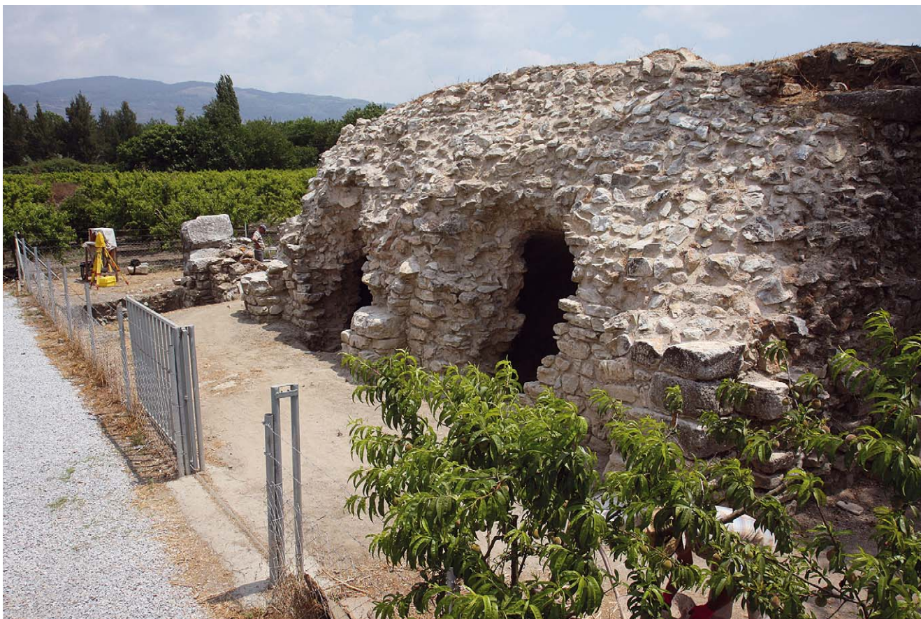
1 Nordfassade nach der Sicherung (2010)
