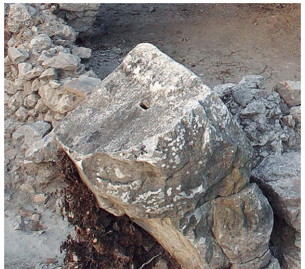
4 Nordfassade, Bogenblock: Zugang Kammer 9
