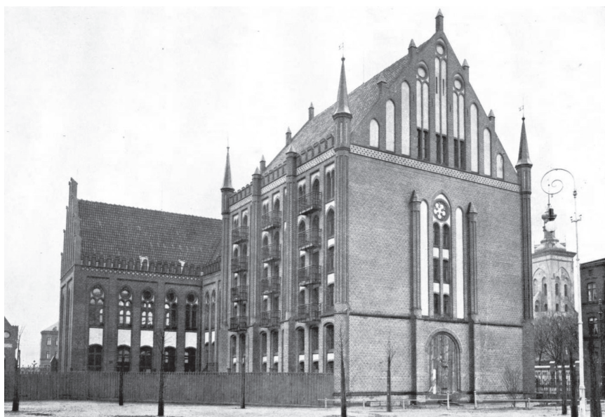
Il. 7. Gmach Biblioteki Miejskiej (Stadtbibliothek) widziany od zachodu, ze skrzydłem magazynu książek (po prawej) i skrzydłem czytelnicy (po lewej w głębi), pocztówka w zbiorach prywatnych
